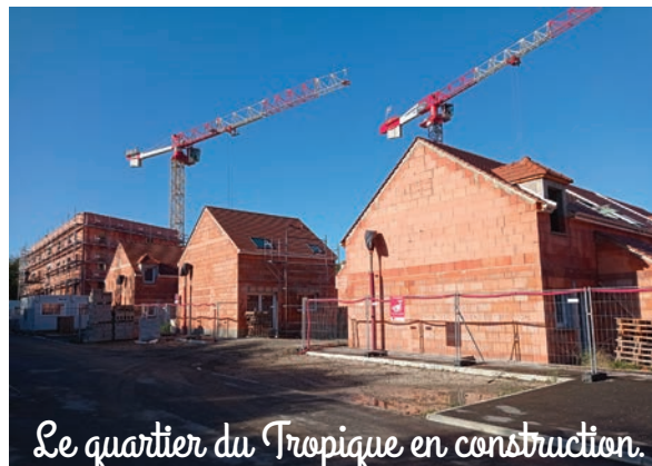
Le quartier du Tropic en construction.
