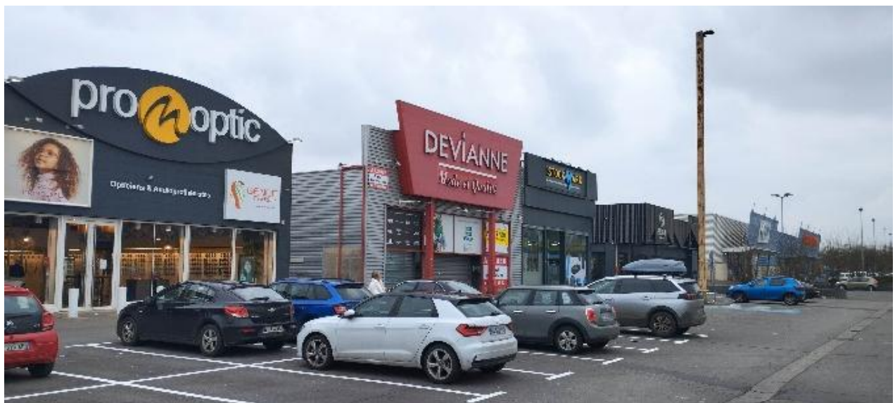
Exemples d'enseignes sur façade ou scellées au sol non conformes
